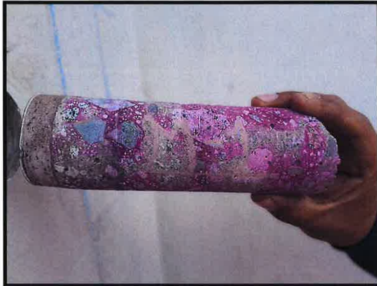
Fig. 04 – Carbonatación Muestra M-5
